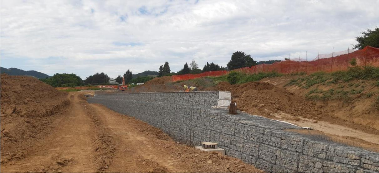
**In corso di completamento la costruzione delle terre Armate Zona sostegno campo di calcio**
